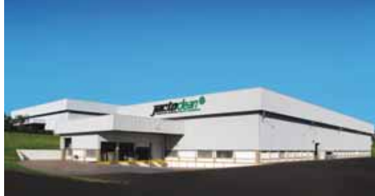
Fachada da fábrica da JactoClean
